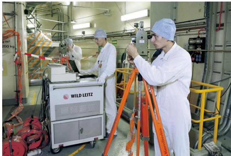
Absteckung der Schweisskanten an den Kühl- mittel-Leitungen mit Axyz und 6 Theodoliten
